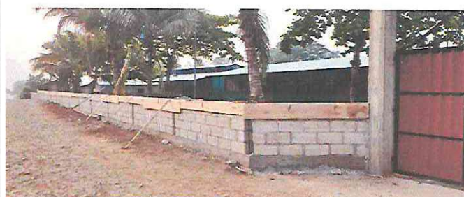
LADO IZQUIERDO FORMALETEADO Y RELLENADO DE CEMENTO
