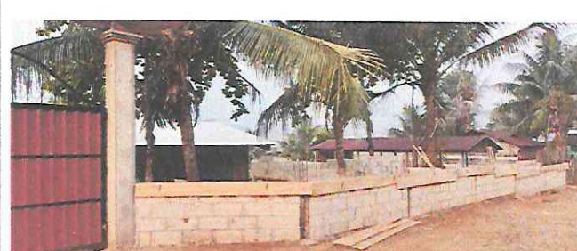
LADO DERECHO FORMALETEADO LISTO PARA SER RELLENADO DE CEMENTO
