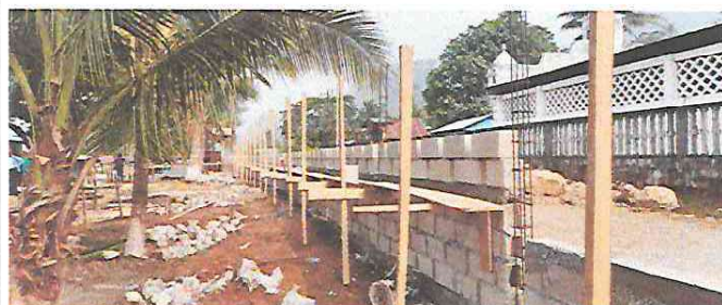
SE OBSERVA LA COLOCACIÓN DE LOS BLOCK'S DESDE ADENTRO DEL ESTABLECIMIENTO
