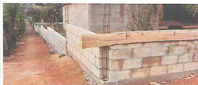
SE OBSERVA EL FORMALETEO DE LA COSTILLA Y RELLENADO DE LA MISMA
